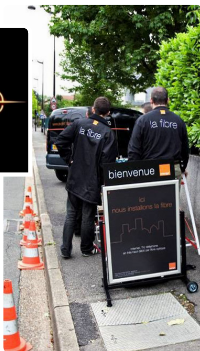
Déploiement de la Fibre in situ © crédit photo : Orange
